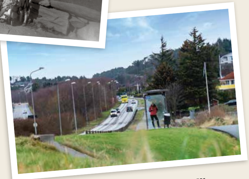
Enokbakken er lettreist. Bussen tar deg enkelt til Stavanger, flyplassen, Sola, Forus og Sandnes.
